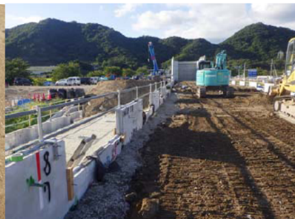
手摺り設置状況
