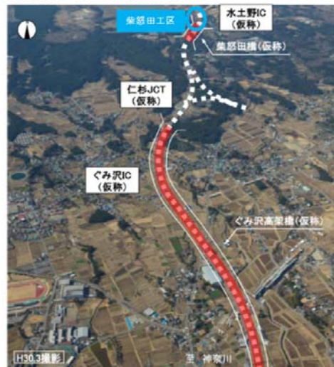
■御殿場バイパス (西区間)
