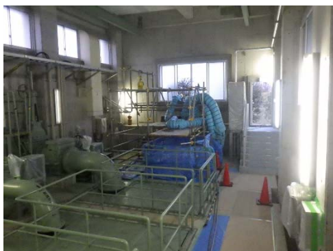
計器類の養生
