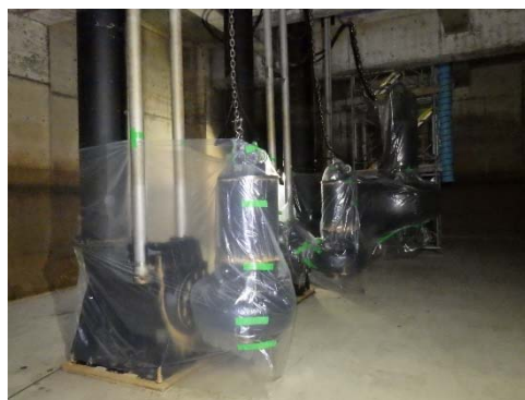
機械類の養生
