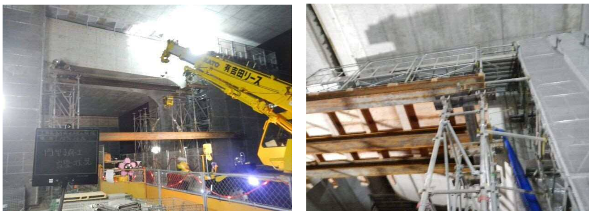
夜間施工による支保工組立
