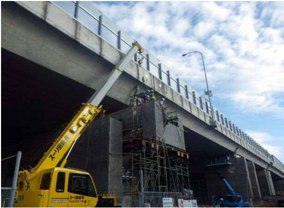
荷揚げ場設置
