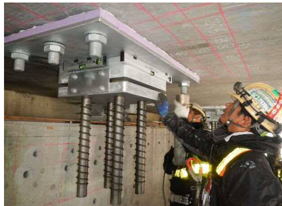
設置完了（水平確認）
