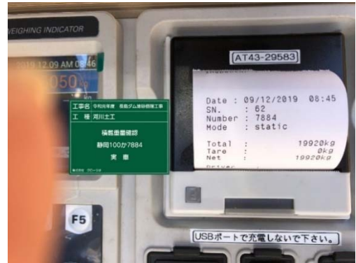
ダンプ総重量確認（トラックスケールによる）
