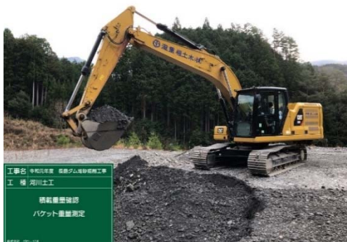
バケット土砂重量測定（ペイロードによる）
