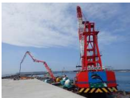
上部工 施工状況
