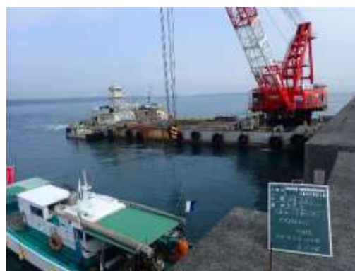
被覆・根固め工 施工状況
