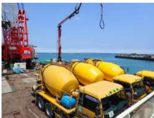
ポンプ車・生コン車積載状況
