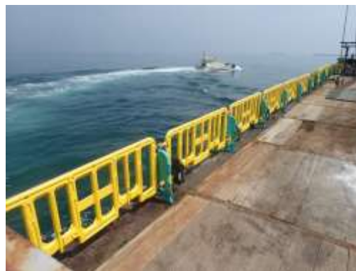
(2) 転落防止の安全柵設置
