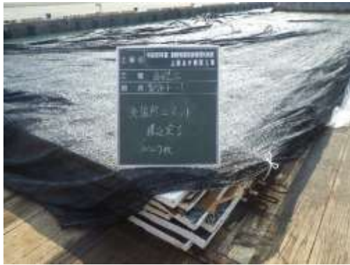
遮光シートによる養生状況
