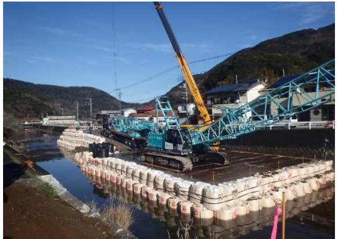
70 t クローラークレーン組立状況
