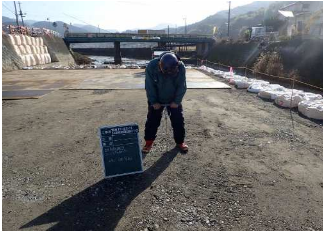
施工ヤード支持力確認
