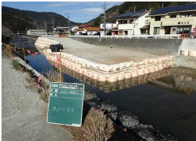
施工ヤード完了
