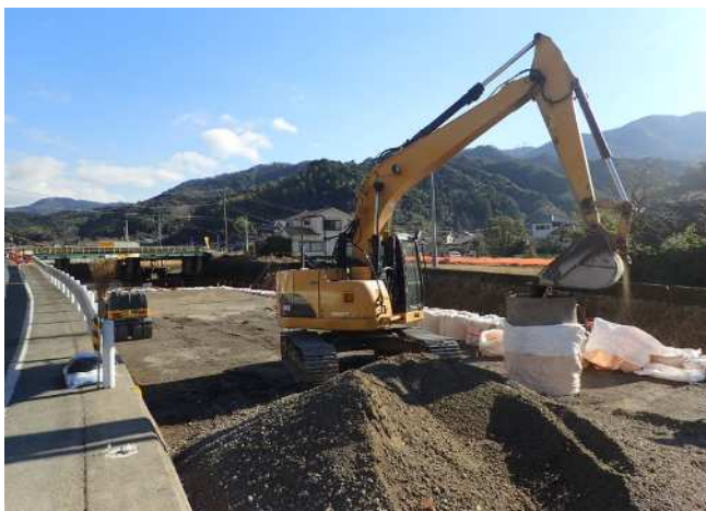
大型土のう制作状況
