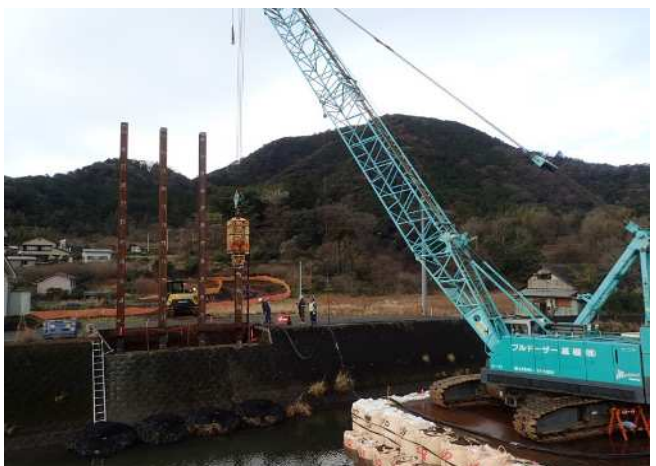
左岸支持杭打設状況
