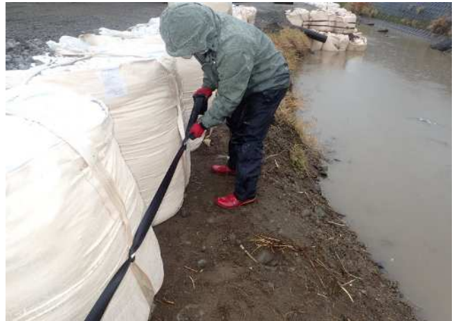
連結補強ベルト設置状況
