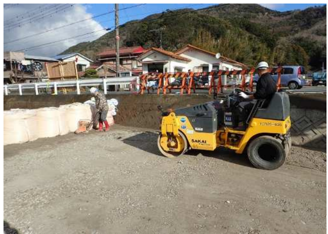
再生盛土材敷き均し転圧状況
