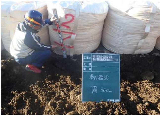
1層30cm巻き出し圧確認状況
