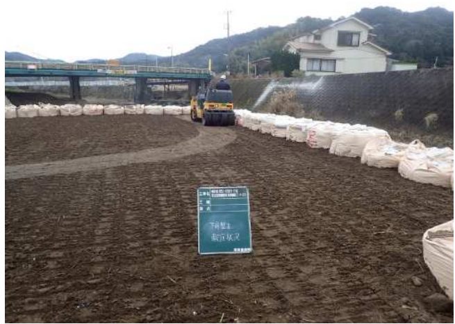
堆積土砂敷き均し転圧状況
