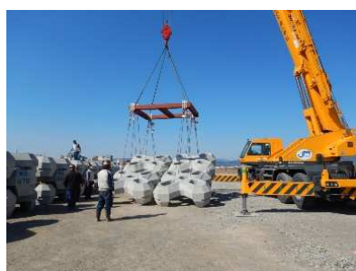
今回使用した吊り形状は6種（1,2,4個吊りの平吊りと勾配吊り）
