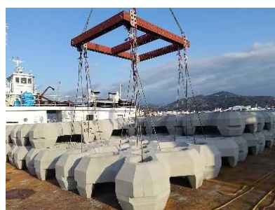
今回使用した吊り形状は6種（1,2,4個吊りの平吊りと勾配吊り）
