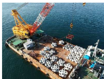
写真① 天秤を使用した水中作業時間の短縮化
