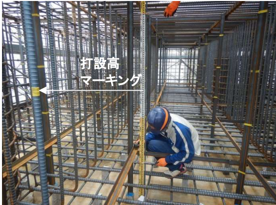
打込み高さのマーキング
