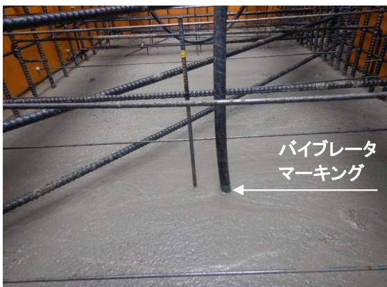
バイブレーターのマーキングによる挿入深さ確認
