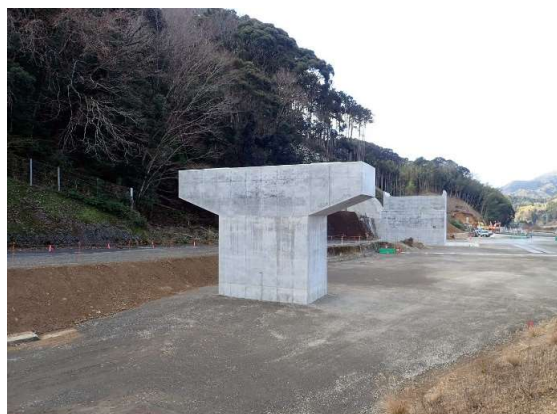
P1橋脚完成
