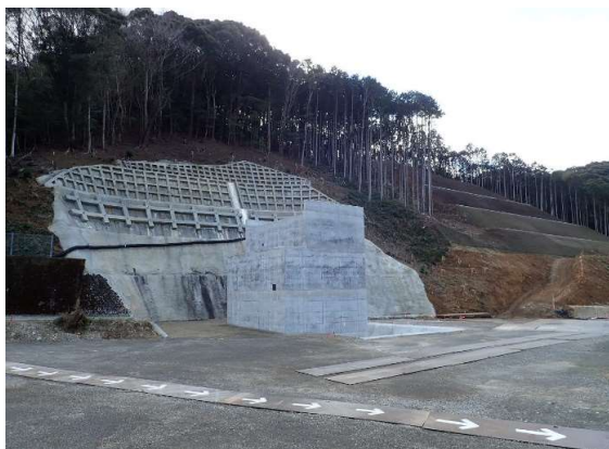
A2橋台完成
