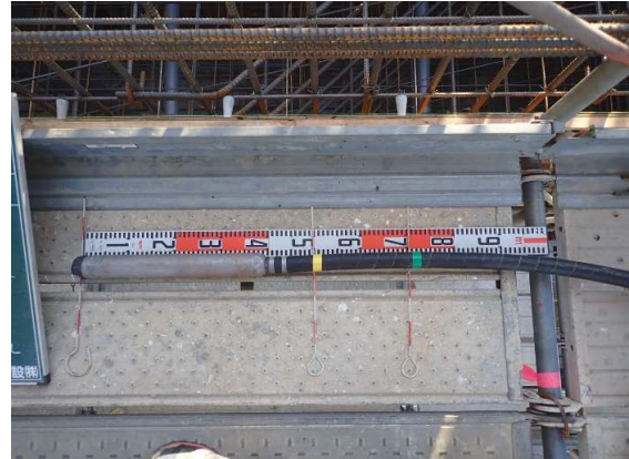
バイブレーターのマーキング
