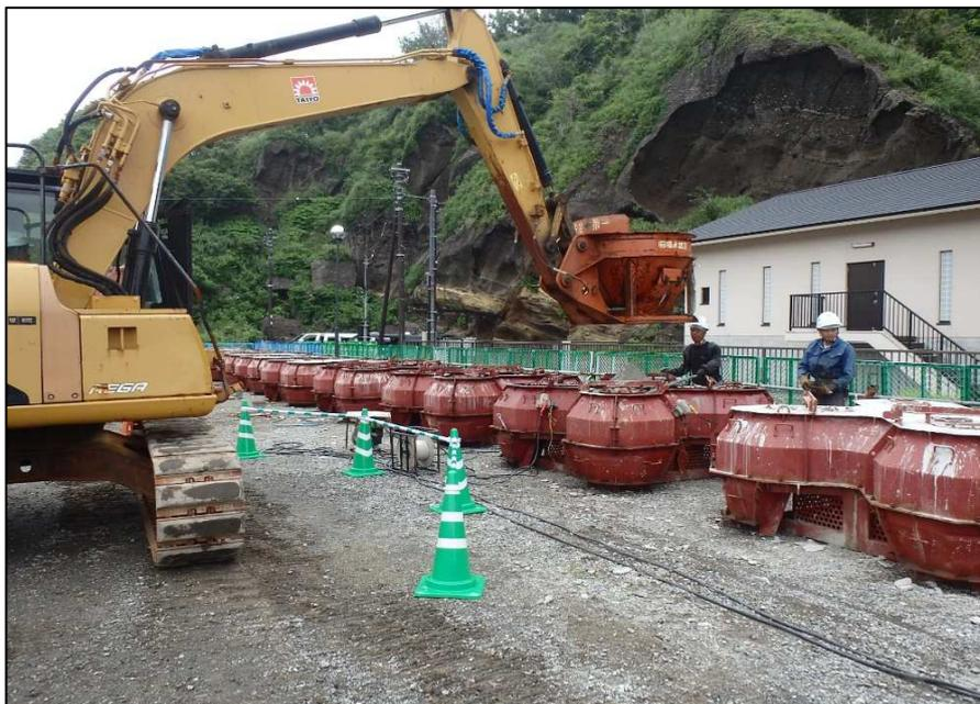
ブロック製作において、型枠上あるいは足場上からの転落災害の要因を無くするため、コンクリート打設用の油圧式コンクリートバケットを、アタッチメントによるバックホウ一体型のものでブロック製作作業を行った結果、常に作業性が良く、冬季の季節風が比較的強く吹くような日でも、生コン車からコンクリートを受ける際及び打設時に、コンクリートバケットの振れを止めるような手間も無く、安全且つ効率良くブロック製作作業を行うことが出来ました。
