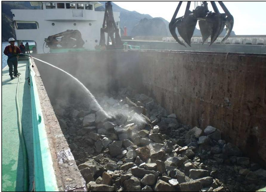
施工箇所周辺は、定置網漁、えび網漁等の地元漁業者の操業範囲内にあり、特に基礎捨石の投入作業時は、漁業者の操業に支障が無いようにする必要がありました。また、施工箇所は地元漁業者の航行箇所にもなっているため、汚濁防止膜を使用すると漁船の出入りの障害にもなるため設置できません。そのため捨石の投入時は、石材運搬船のホールド内で石材の砂塵を洗い流し、洗い流した水は石材運搬船の外部へ放出することなく捨石投入作業を行った結果、汚濁の状態は最小限におさえられたため、漁業者からクレームが出ることなく、捨石投入作業を行うことが出来ました。
