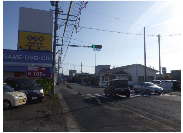
仮信号機設置完了
