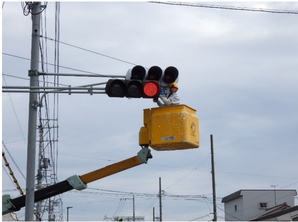
信号機の付替え状況
