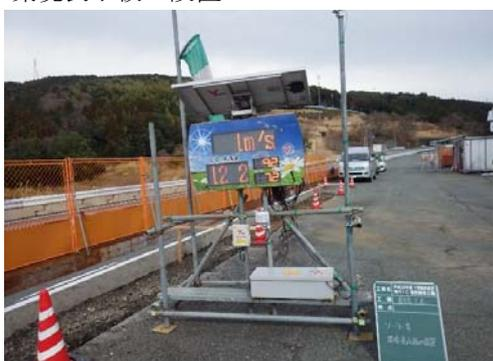
風速がリアルタイムで表示され、又、作業従事者やクレーンオペレーターの運転席からでも見える様な大きなパネル表示器となっている為、吊り作業時の中止の判断等が随時行えた。
