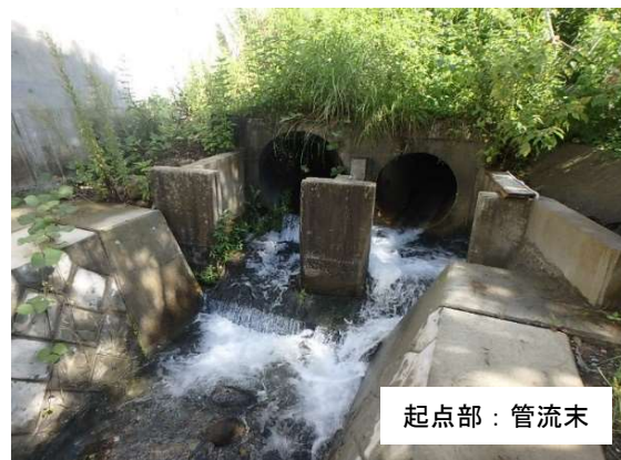
— 流速対策工：着手前 —
