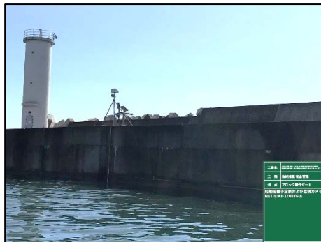
防波堤先端への監視カメラ設置状況
