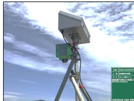
防波堤先端への監視カメラ設置状況
