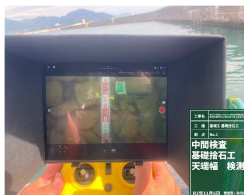
動画による出来形検測状況
