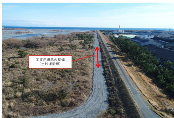
工事用道路設置完了 (掘削箇所～盛土箇所間L=2.0km)
