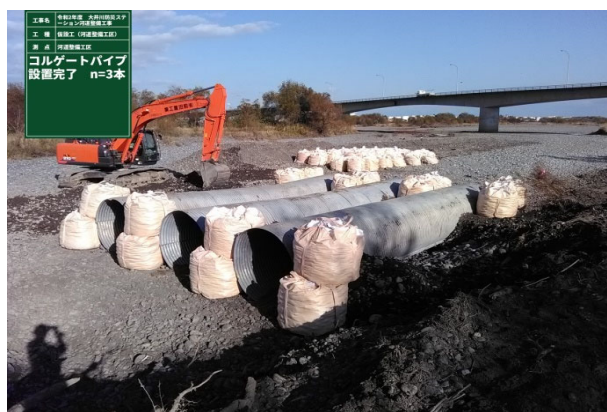
コルゲート管設置
