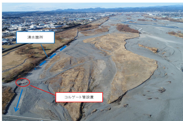
掘削箇所全景
