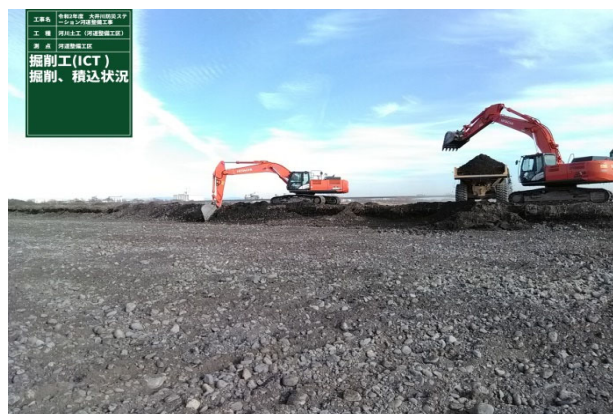
バックホウによる掘削、整形
