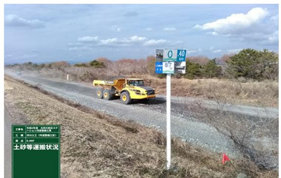
重ダンプ（40 t 級）を3台使用したことで、河道掘削範囲内もスムーズに走行することが容易なため作業効率を向上させ、工程を厳守した。
