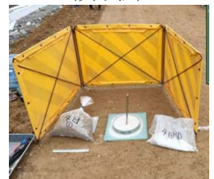
現場密度試験 (突砂法)
