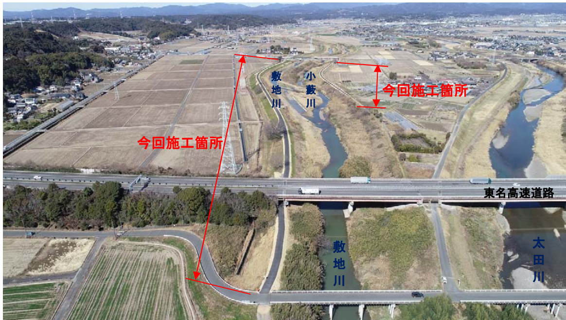
完成時の写真(全景)
