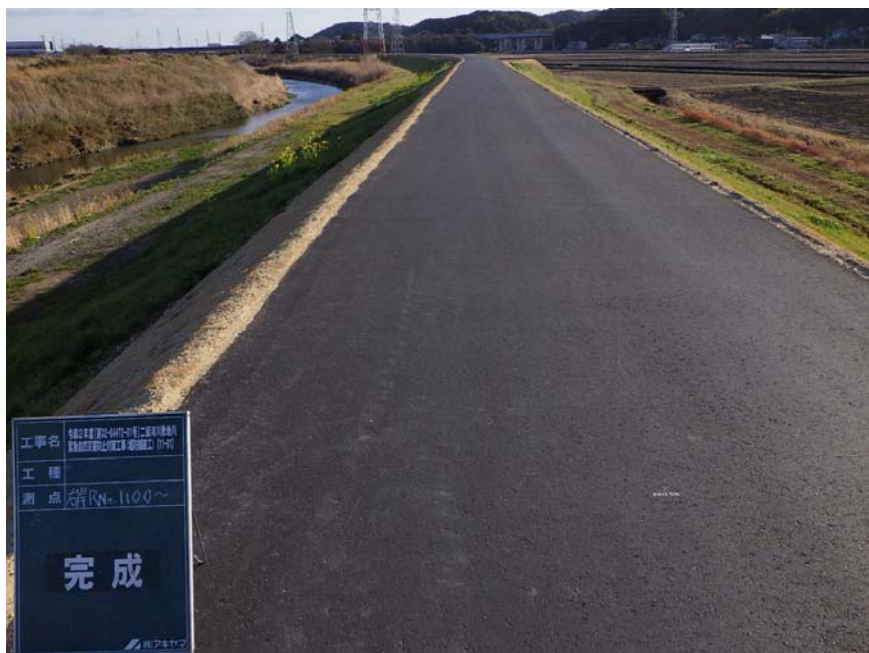
完成時の写真(右岸側No.1100付近)
