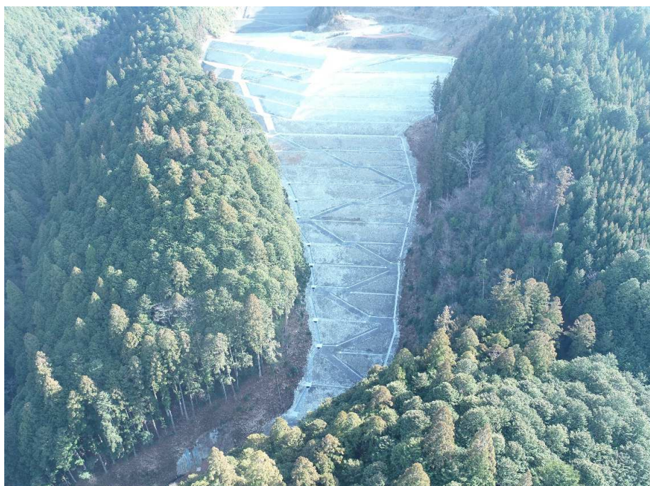
写真 排水構造物完成写真(ドローンにて撮影)
