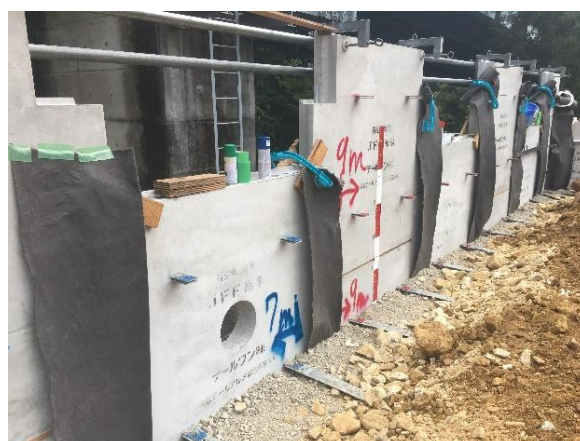
写真3 色分け(壁面材側)
