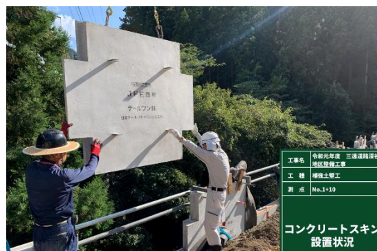
写真6 壁面材設置状況
