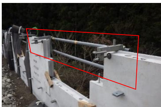
写真5 ベランダガード転落防止柵
