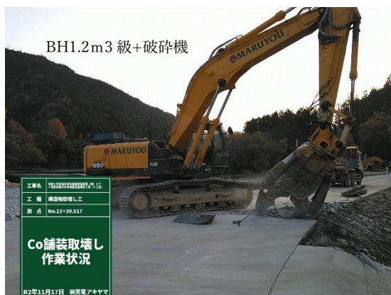
Co 舗装版 大割作業
