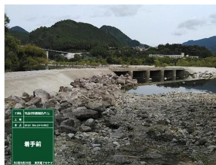
着手前（潜水橋）
