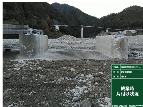
終業時片付け状況（潜水橋付近）
