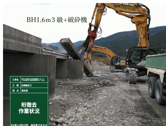
上部工 撤去作業
