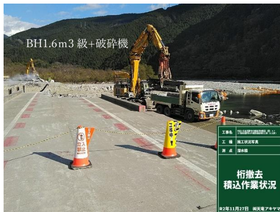
上部工 大割・積込作業
