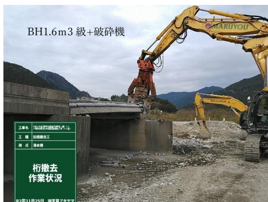
上部工 撤去作業
