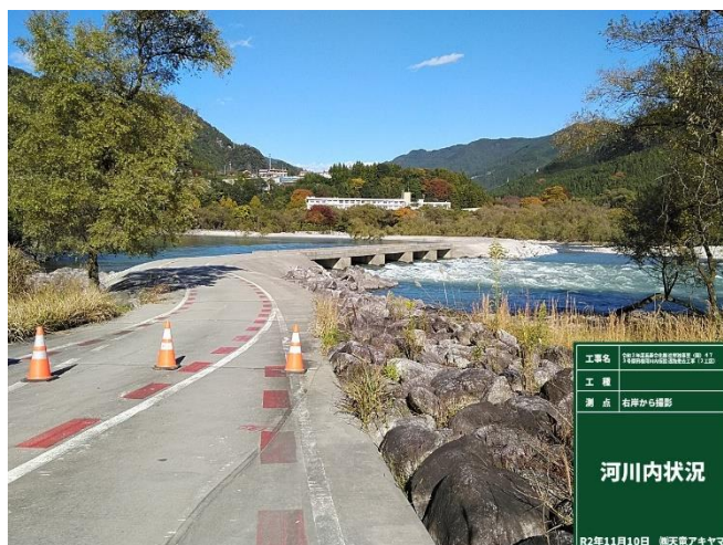
令和2年11月10日 佐久間ダム計画放流時の 河川内状況 (放水量 85t/s)
