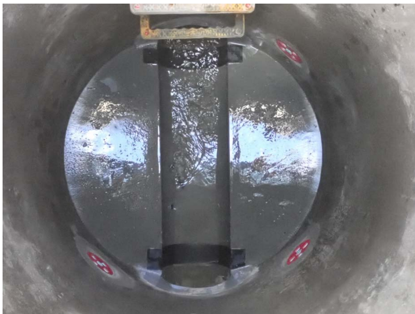
図-4 フロートレス工法、非開削による既設人孔取付部耐震化工法にて施工を施したマンホール内部の写真
