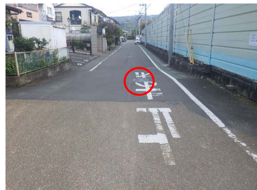
図-2 住宅地等と隣接した施工箇所
