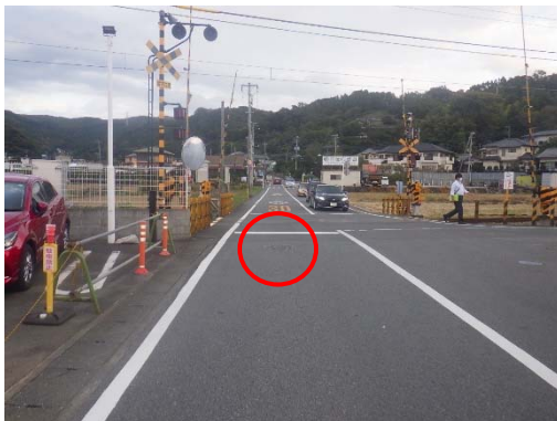
図-1 踏切と隣接した施工箇所
