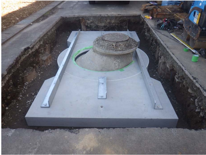
図-3 ハットリング工法にてハットリングを設置した際の写真
