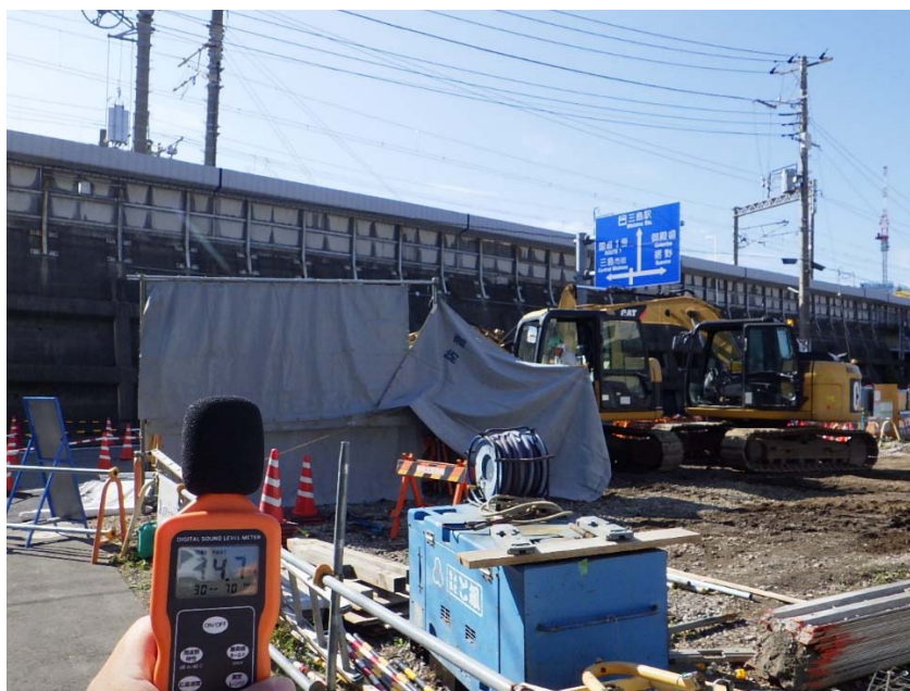
写真：掘削箇所騒音対策及び測定状況
