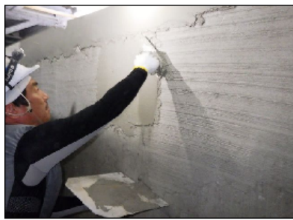
断面修復材塗布状況
