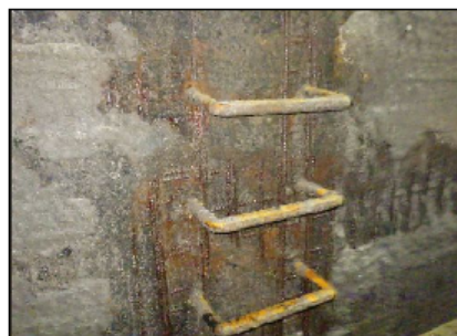
1号排水タンク 高压洗浄後
