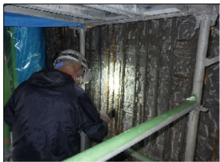
鉄筋処理 防錆材塗布状況
