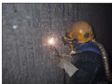
鉄筋処理 フレア溶接状況
