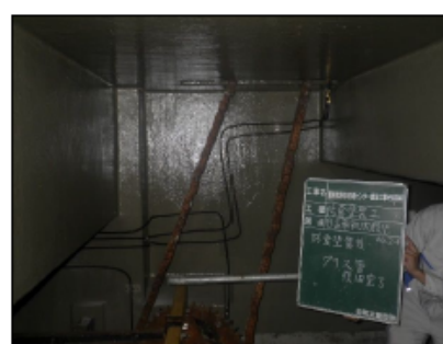
グリス配管一時撤去・再設置
