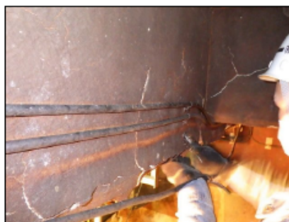
グリス配管一時撤去・再設置
