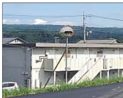
カーブミラーの設置
