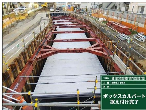
写真-13 ボックスカルバート据付完了
