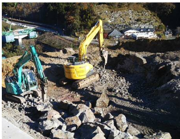
中硬岩掘削状況(小割)
