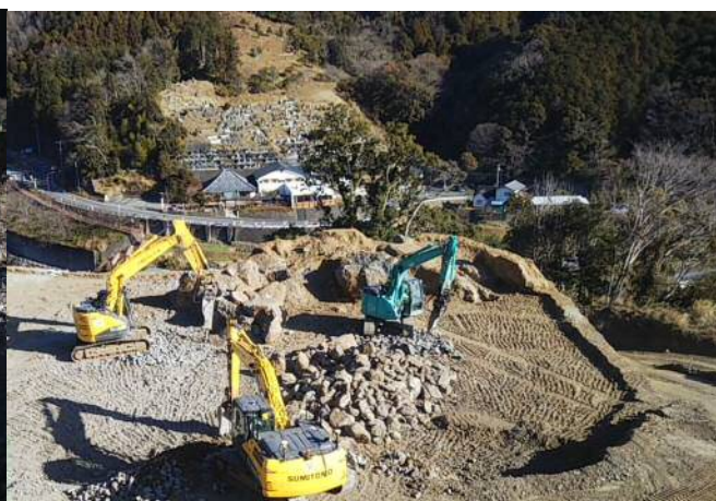
掘削状況(全景)
