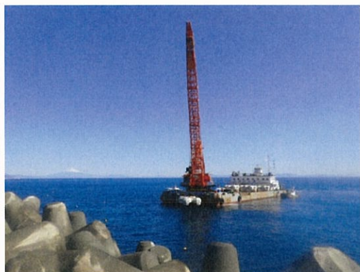
図-2 施工状況①
