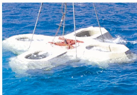
図-4 水中位置検出装置装着状況 (据付ブロック)
