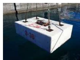
ブロック吊り上げ状況
