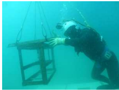
据付作業 (水中写真)
