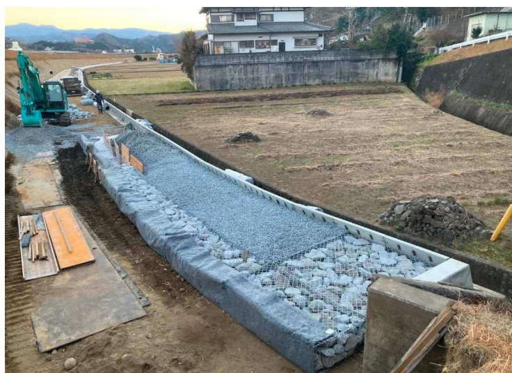
※ドレーン設置状況
