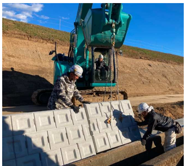
※堤脚保護ブロックの設置状況 (自動追尾TSにて高さを即座に計測・確認)
