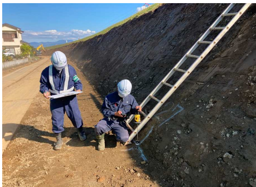
※自動追尾トータルステーションを用いた計測
