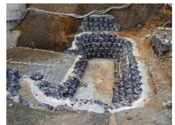
写真-14 垂直壁コンクリート打設 (間詰工を含む) 写真-12 大型土のうを積立てた状態 写真-13 床付け完了
