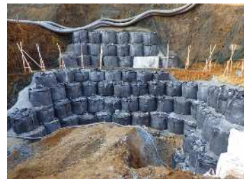
写真-14 垂直壁コンクリート打設 (間詰工を含む) 写真-12 大型土のうを積立てた状態 写真-13 床付け完了
