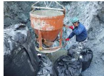
写真-10,11 裏込めコンクリートの打設充填
