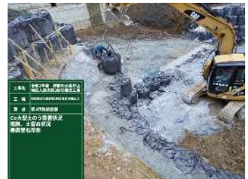
写真-8 温泉余土法面の掘削 写真-9 大型土のう積立て
