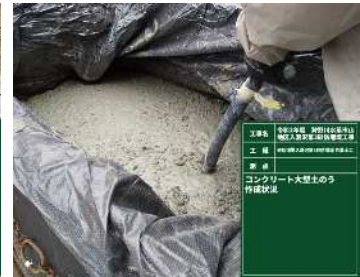
写真-6,7 コンクリート大型土のうの制作 (バックヤード)
