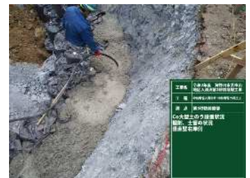
写真-10,11 裏込めコンクリートの打設充填
