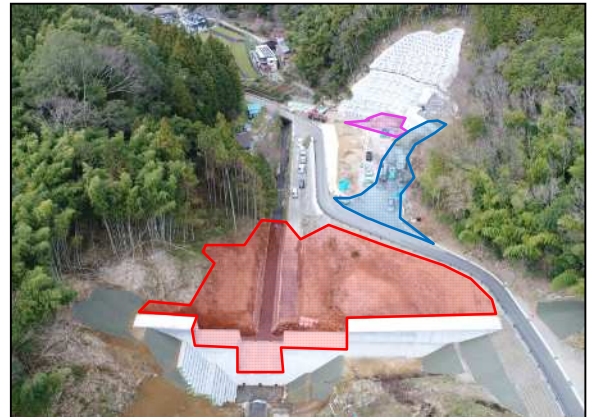
写真-2 着手前全景 本川上流側より望む
