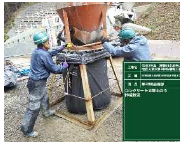
写真-6,7 コンクリート大型土のうの制作 (バックヤード)
