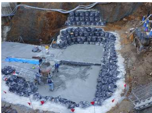
写真-14 垂直壁コンクリート打設 (間詰工を含む) 写真-12 大型土のうを積立てた状態 写真-13 床付け完了
