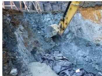
写真-8 温泉余土法面の掘削 写真-9 大型土のう積立て
