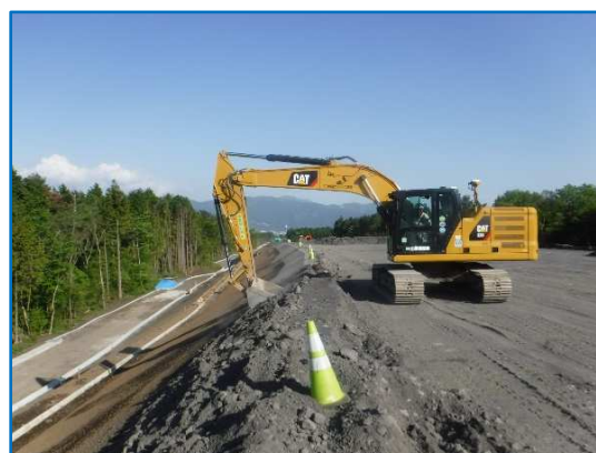
法面整形工施工状況
