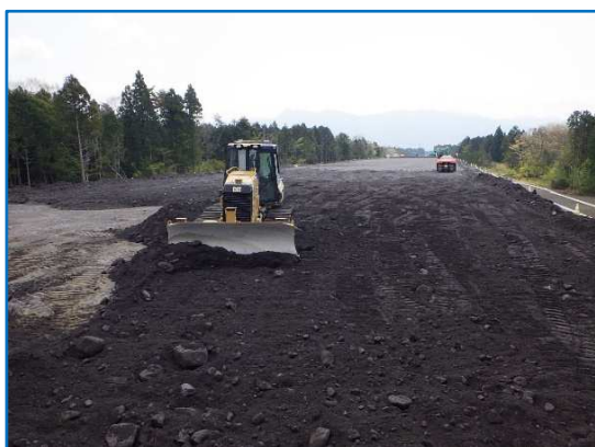
路床盛土工施工状況
