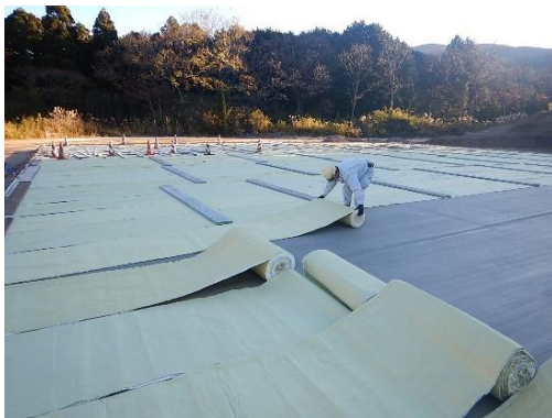
コンクリート養生（養生マット）
