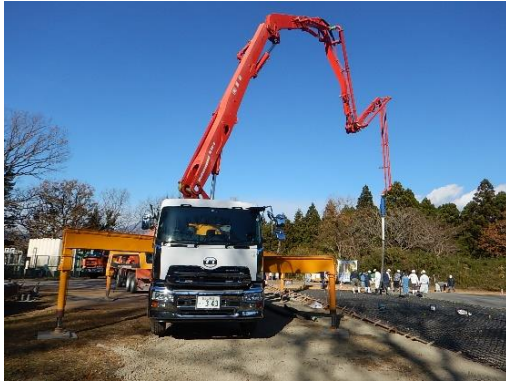
コンクリートポンプ車
