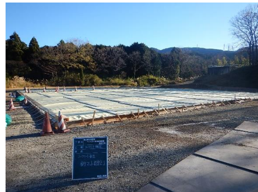
コンクリート養生状況
