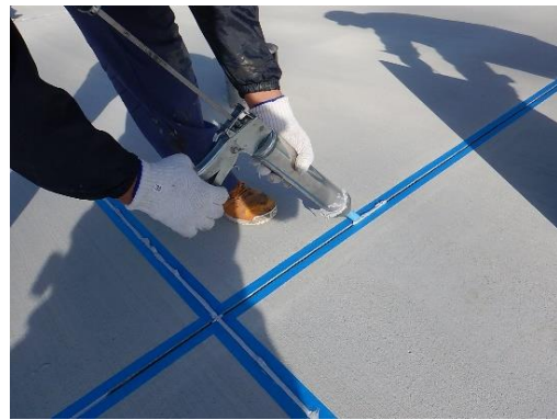
シーリング材充填状況
