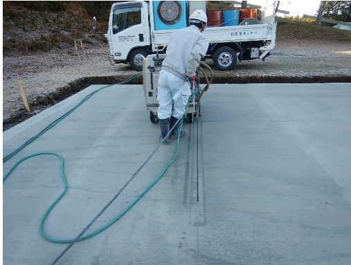
カッター施工状況
