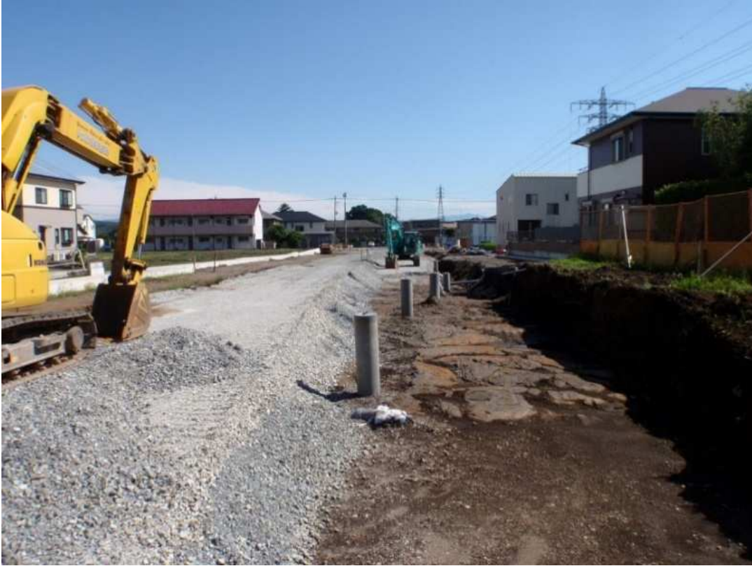
左片側路床施工
