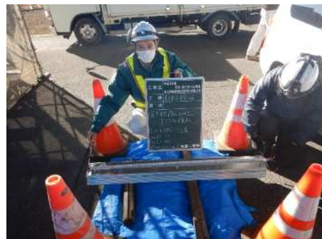
設置部材確認状況
