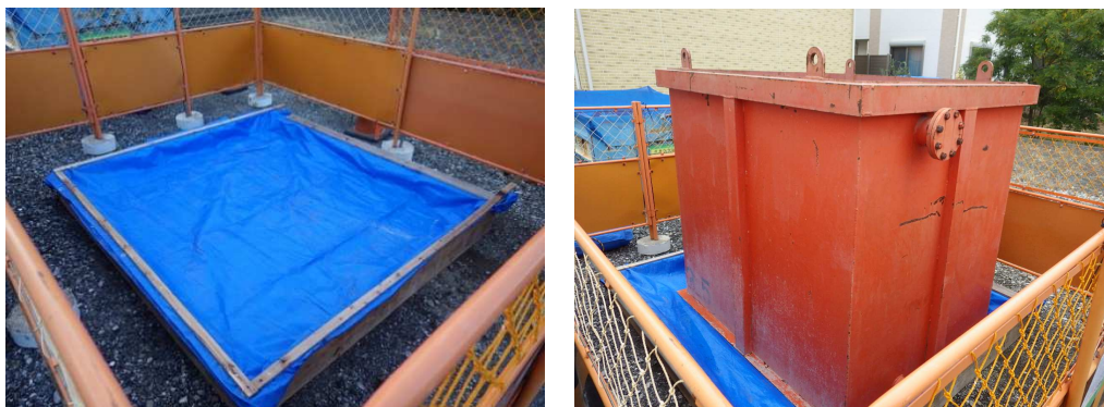
図 2-5. 表面処理によって発生した汚泥の保管場所
