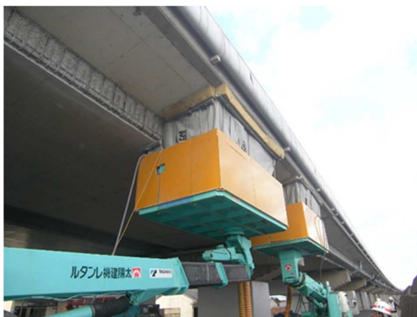
図 2-4. デッキ部養生
