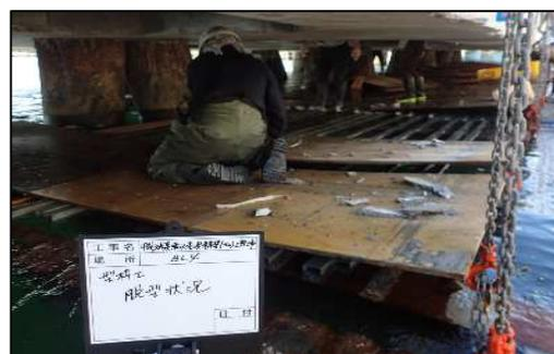
写真 5-6 梁底脱型状況
