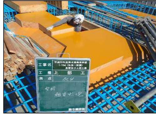
写真 5-3 箱抜き型枠組立状況
