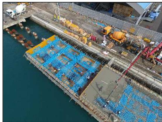
写真 5-2 次 BL 梁鉄筋組立作業
