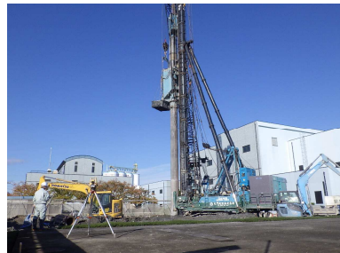
新設杭施工状況 (中堀拡大根固め工法)
