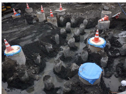
既存杭埋設状況写真
