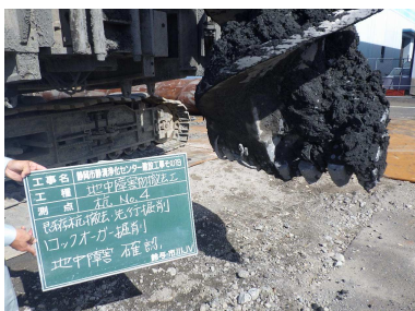
ドーナツオーガー工法により 撤去された既存杭
