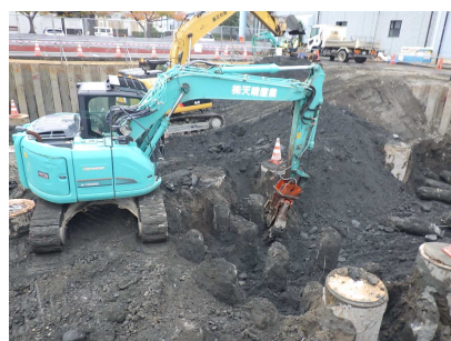
既存杭撤去状況写真
