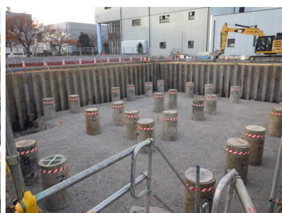
既存杭撤去完了
