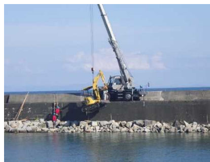
バックホウ設置
