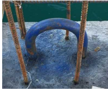
ケーソン吊上げ鉄筋
