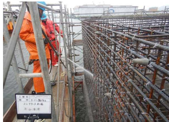
型枠建込前鉄筋洗浄
