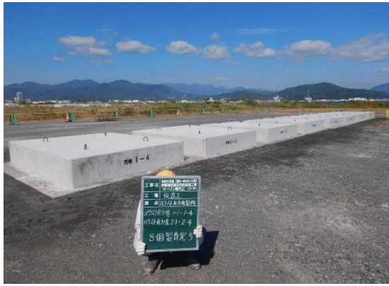
バラスト方塊製作完了
