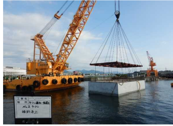
補助吊り浮上状況
