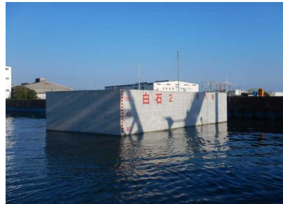
海上施工完了
