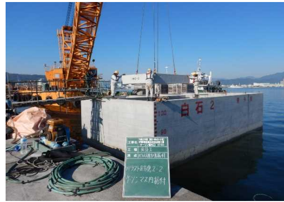
バラスト方塊 投入状況
