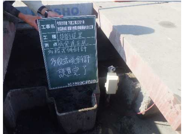
写真 6：多段式傾斜計の設置
