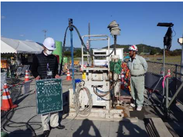
写真 3 : 薬液注入施工
