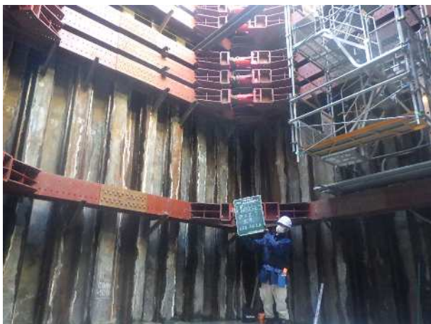
写真 8 : 立坑完了全景
