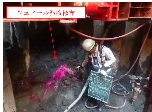
写真 4:立坑内改良確認
