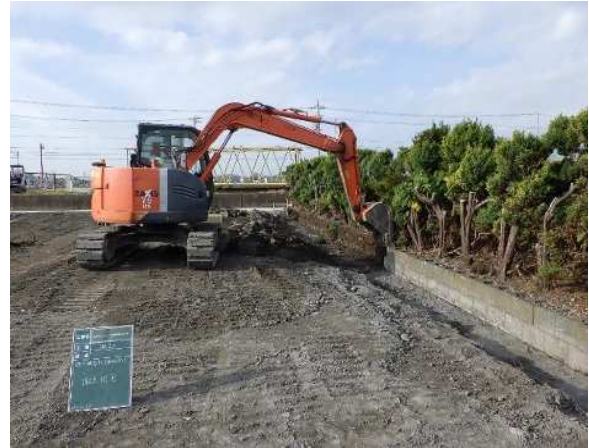
既設ブロック積撤去状況
