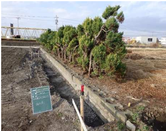
既設ブロック積撤去前
