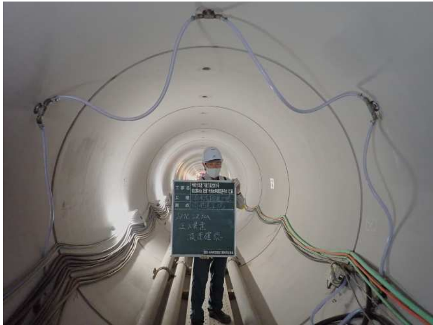
写真 6：滑材注入状況
