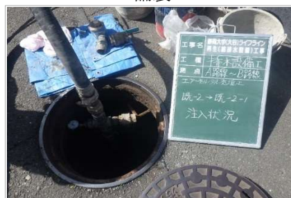
既設管撤去工(エアモル充填)
