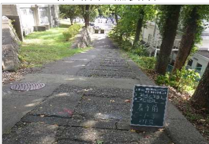
着手前(Co舗装部)
