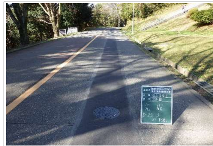
完 成(As舗装部)
