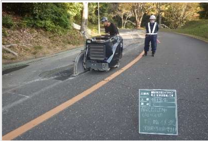
舗装影響線切断工
