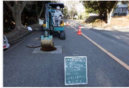
既設柵撤去工
