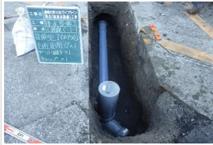
既設管接続工
