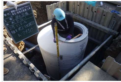
マンホール設置工
