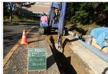
管布設工 根切工
