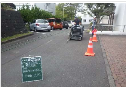
既設舗装切断工
