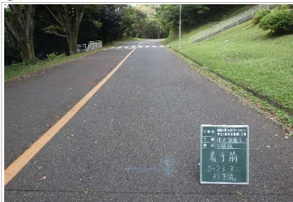
着手前(As舗装部)
