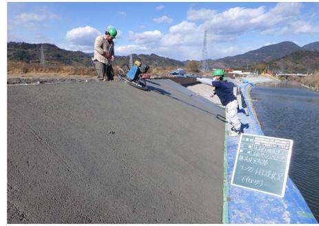
(写真-4 円盤付機械ゴテ仕上げ状況)
