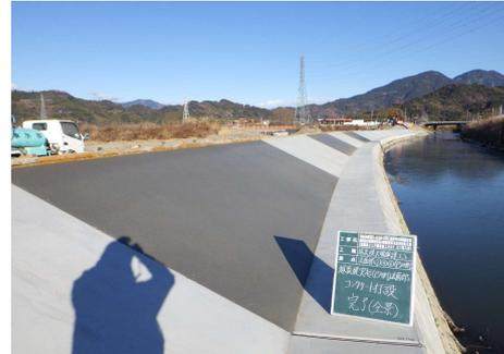
(写真-6 法面部②打設完了)
