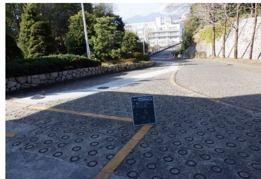
完成写真（農学部付近）
