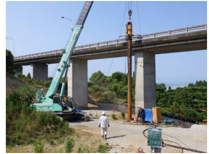
写真-3 ダウンザホールハンマー工法
