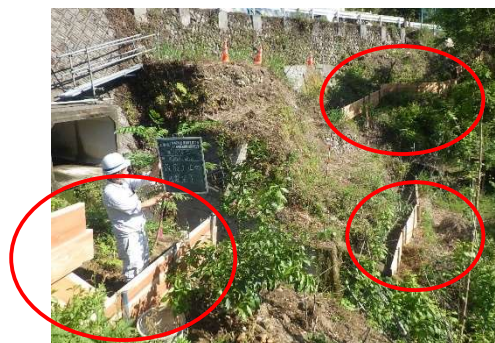
写真-7. 仮設土留柵
