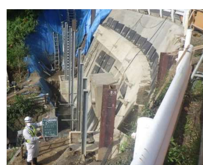
写真-6. 場所打杭工完了
