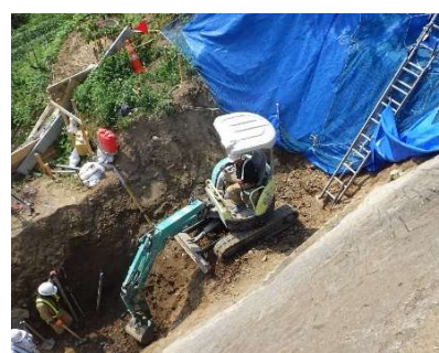
写真-3. 掘削状況 (0.10 m 3 バックホウ)
