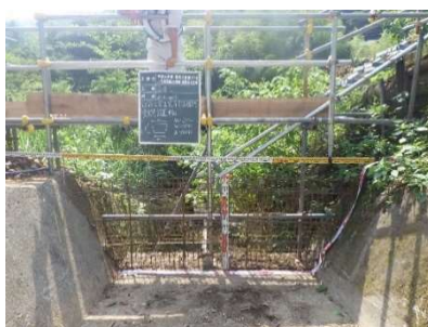
写真-9. 金網設置
