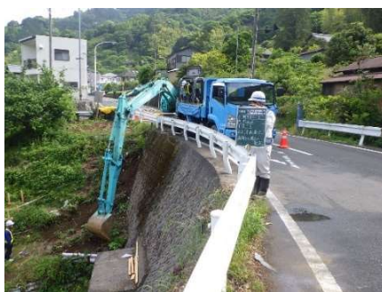
写真-2. 掘削状況
