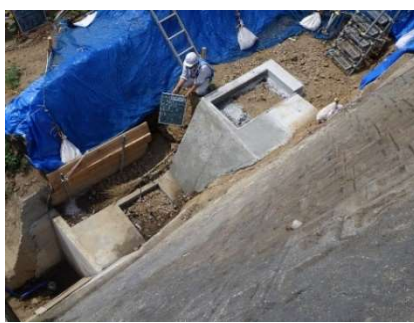
写真-5. 均しコンクリート(終点)
