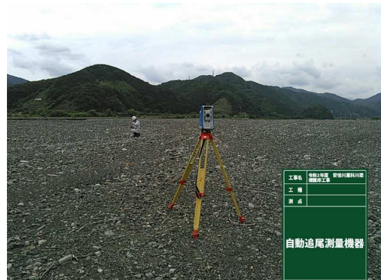
写真-3 測量作業状況
