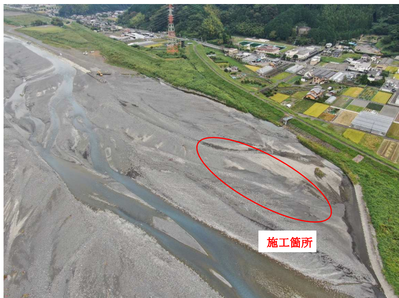
写真-1 安倍川左岸13.75KL 付近を望む
