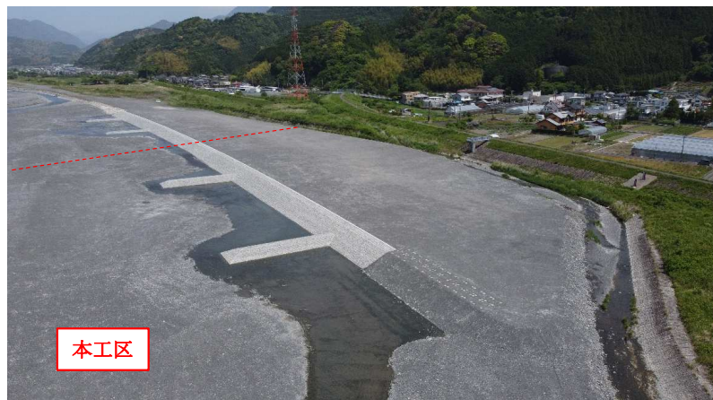
写真-4 完成写真
