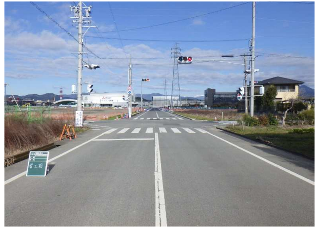
写真2：着手前(工事終点側)
