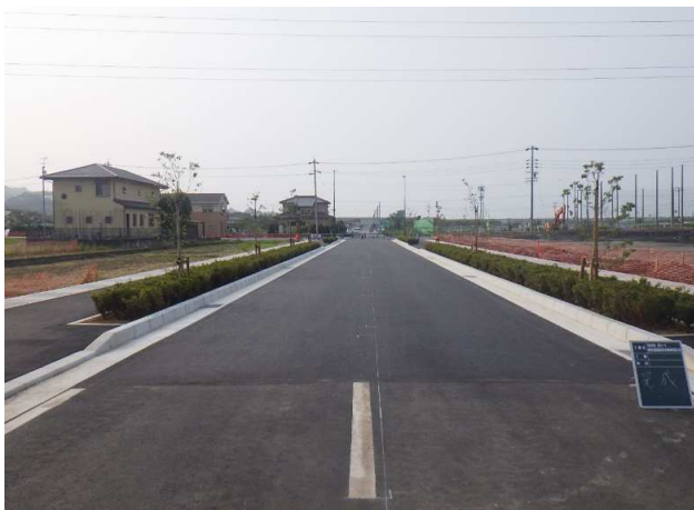
写真3：完成(工事起点側)
