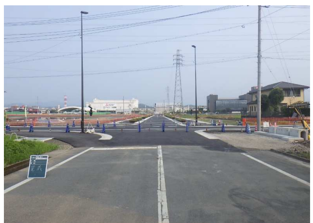
写真4：完成(工事終点側)
