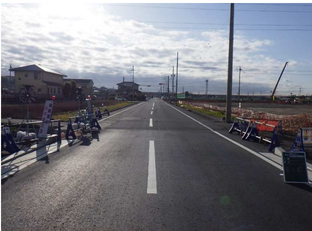
写真1：着手前(工事起点側)
